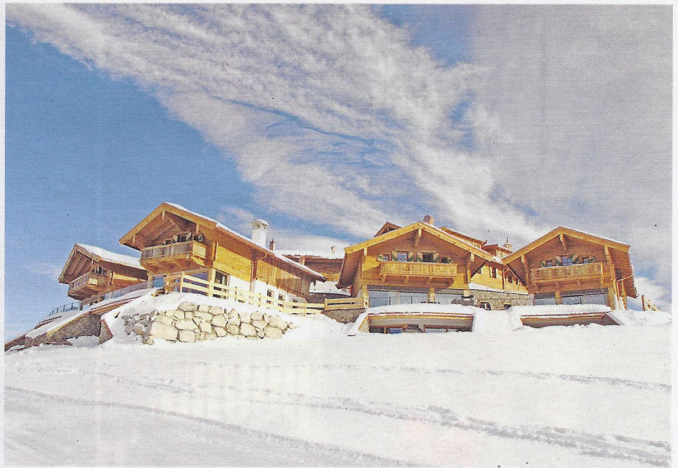
Rauf auf die Bretter: Die fünf Maierl Chalets liegen mitten im Skigebiet von Kitzbühel in Österreich, die Gäste können direkt am Haus ihre Skier anschnallen und losfahren
